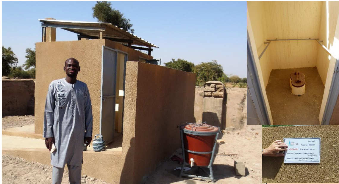
M. Bengaly devant les latrines de Diakobougou
