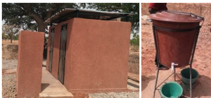
Un bloc de latrines et un lave-mains, implantés dans une école.
